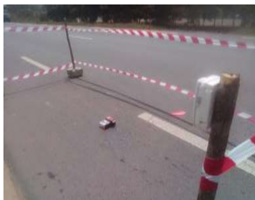
Photo 4 : Dispositions de mesure de températures
